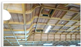
▲二階中央にある講堂の天井。鏡板は全て無節の桧杵目板。
